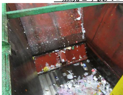
__ 燃焼ごみ投入ビット(一階)
